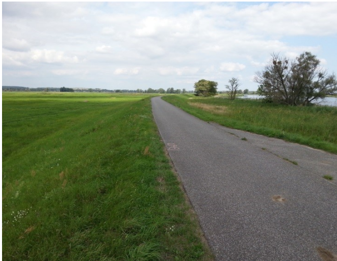
Abb. 3: Blick auf den Altdeich im Baulos 69 (Foto: G. Fromhold-Treu, LfU W21)
