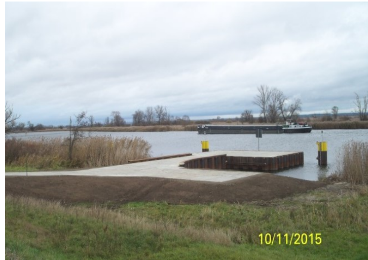
Abb. 4: Schiffsanleger für den Antransport von Schüttgütern (Foto: G. Fromhold-Treu, LfU W21)
